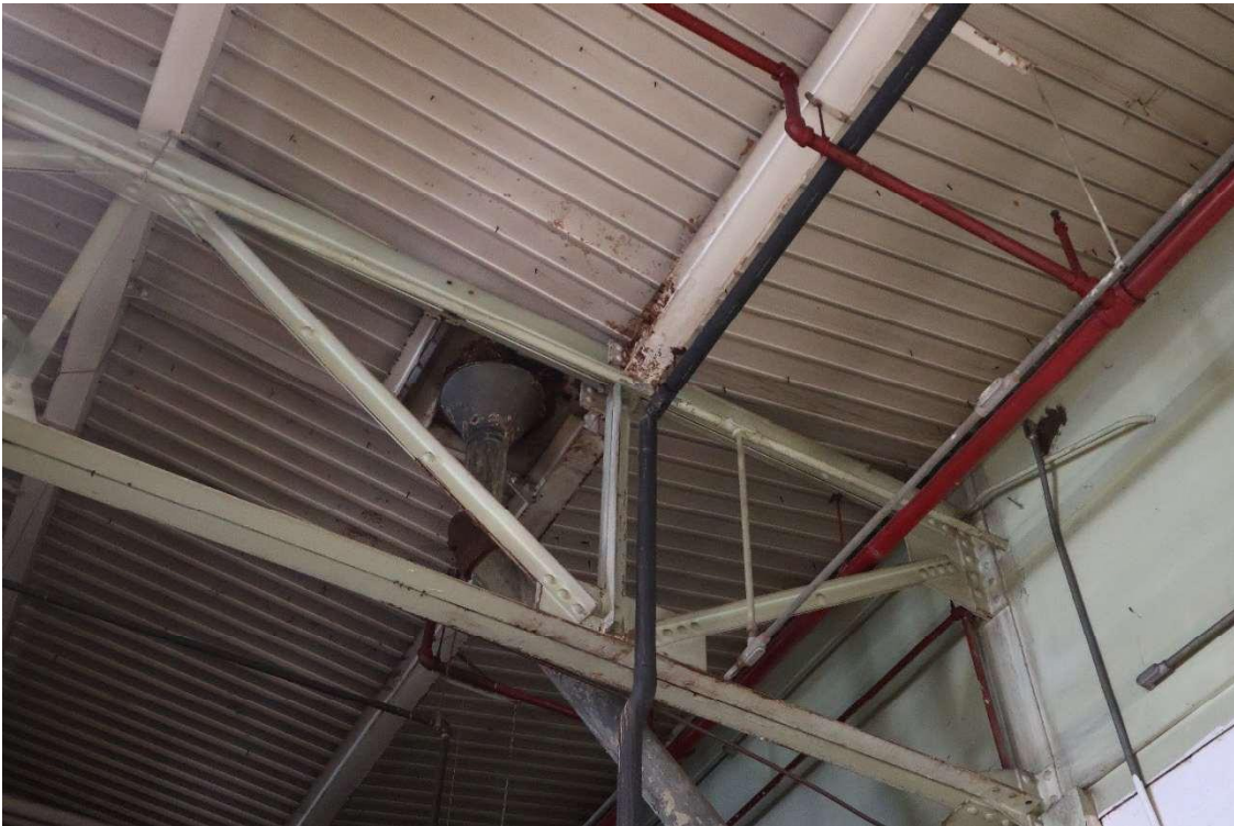
Roof at column D15
